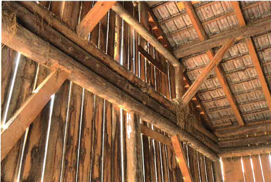
Abb. 14: Heuwalmen: Innenansicht der Ostfassadenwand in Rundholz-Konstruktion von 1821. Img 2014-06-10/768
