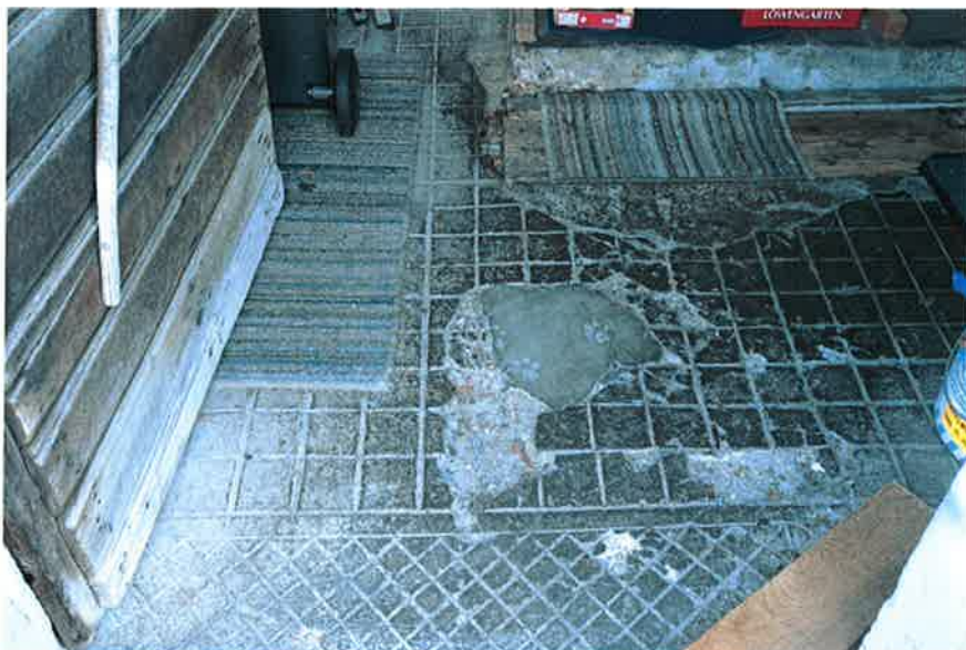
Abb. 10: Stall, Detail: Betonboden mit strukturierter Ober- fläche, [1941]. Img 2014-06-10/764
