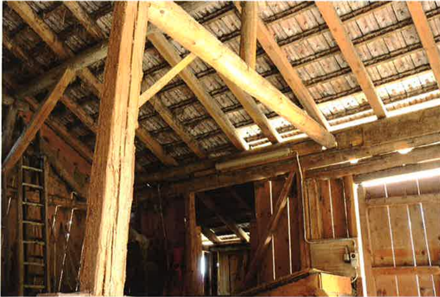
Abb. 16: Heuwalmen: Nordwest- bereich, 1821; hinten der Dachraum über dem Schweineestallanbau. Img 2014-06-10/770
