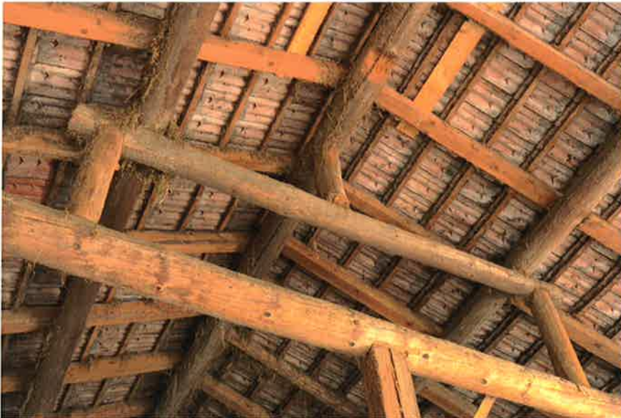
Abb. 17: Dachstuhl von 1821. Img 2014-06-10/771
