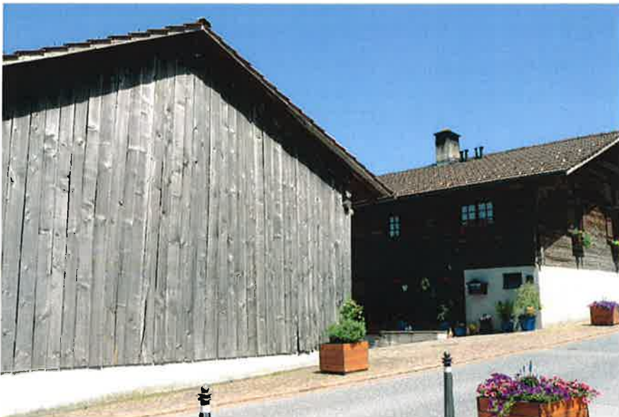
Abb. 4: Südostansicht mit der Stallscheune von 1821 und dem Wohnhaus von 1774. lmg 2014-06-10/752
