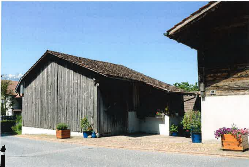
Abb. 3: Ostansicht der Stallscheune von 1821. lmg 2014-06-10/751
