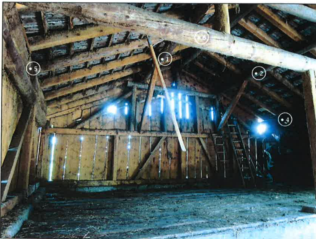
Scheune - Innenansicht gegen Norden
