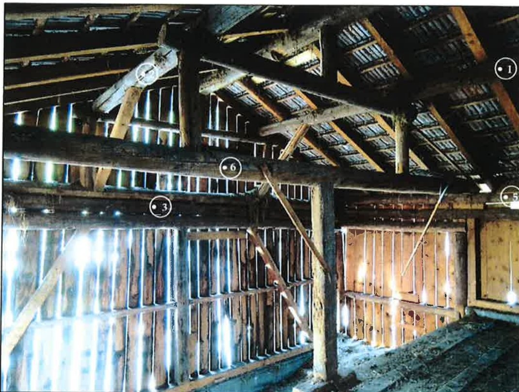
Scheune - Innenansicht gegen Süden
