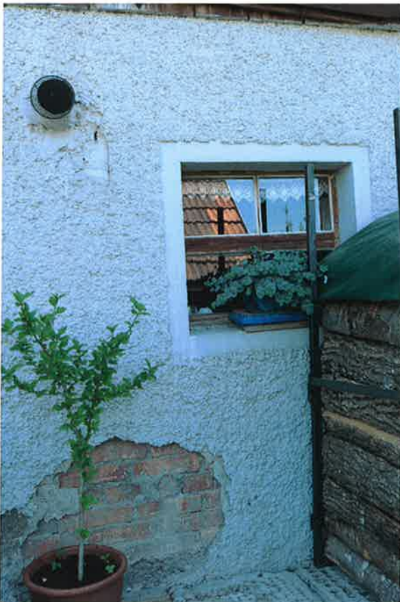
Abb. 9: Westfassade , Detail: Stallwand in Backstein- mauerwerk, überputzt; Fenster in Putz, [1941]. Img 2014-06-10/763
