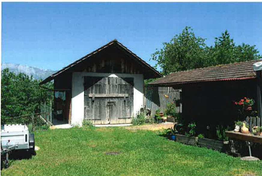
Abb. 18: Freistehender Schuppen, erbaut 1960; Südostansicht (Bauakte 1960-36). Img 2014-06-10/759
