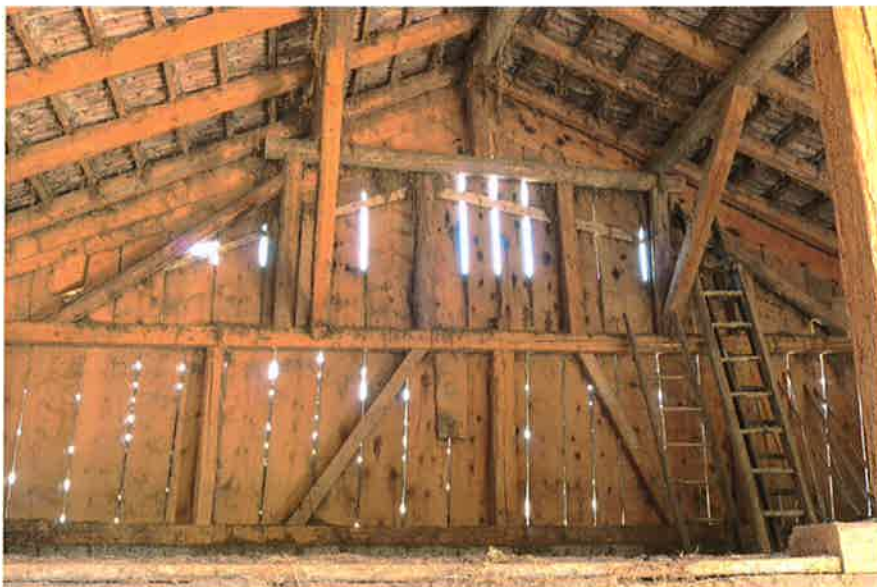
Abb. 15: Heuwalmen: Innenansicht der Westfassadenwand in Rundholz-Konstruktion von 1821; Wände 1. H. 20. Jh. [1941/47] mit mechanisch gesägtem Gebälk teils erneuert. Img 2014-06-10/769
